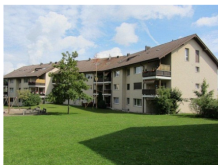
Abb.1: Block 5 bestehend aus drei Teilgebäuden
